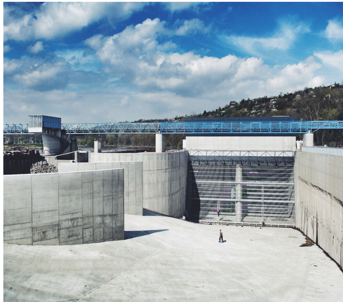
Dokončená stavba MVE Štětí vtokový objekt
